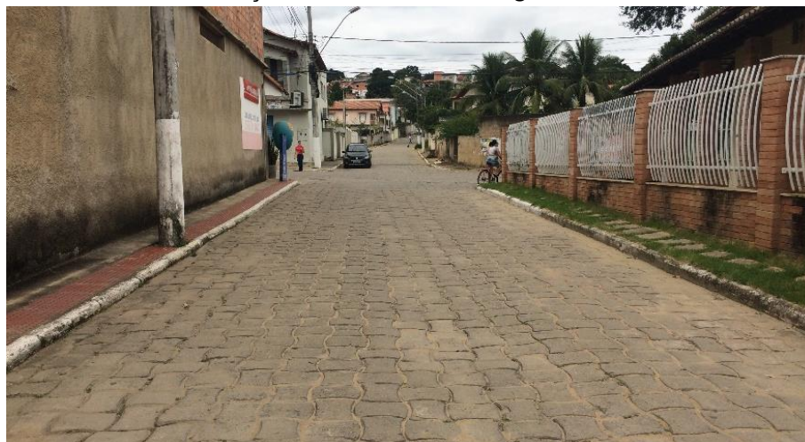
Foto 4: Via com calçadas estreitas e irregulares.
