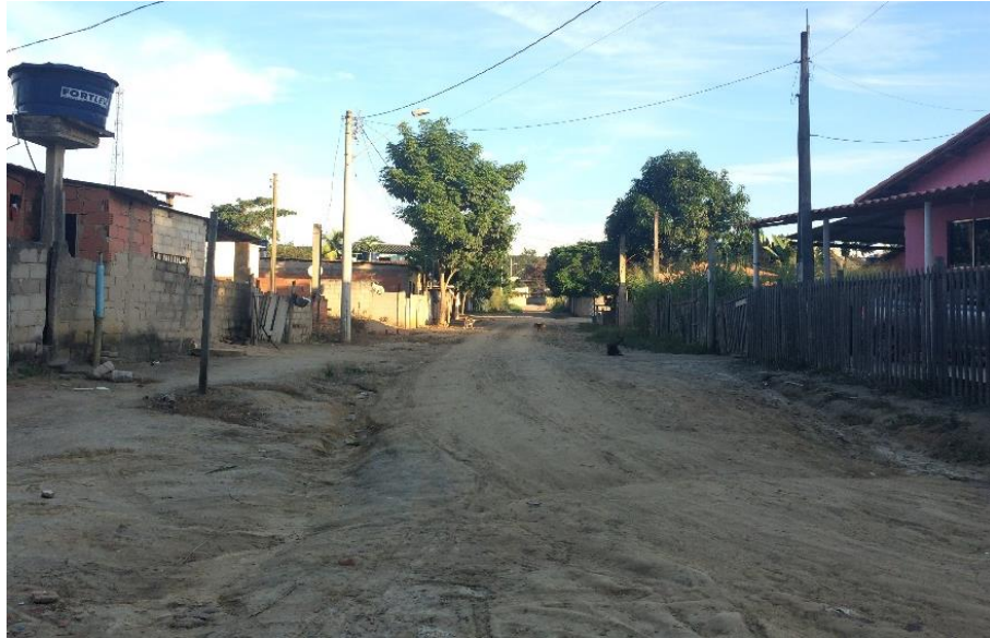
Foto 1: Rua sem pavimentação.
