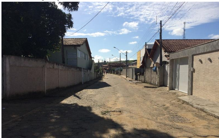
Foto 10: Vegetação inexistente na via.
